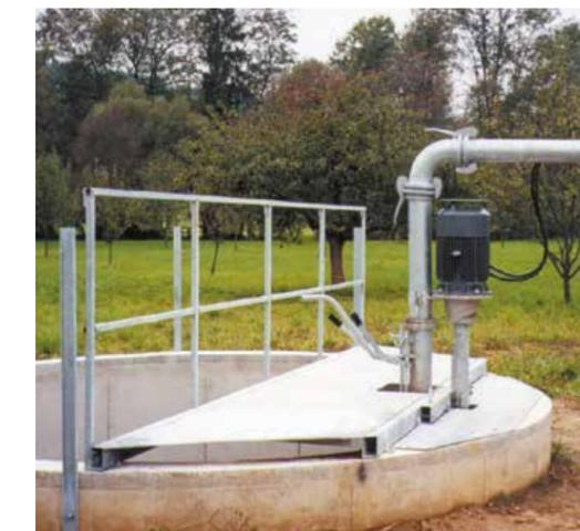
Насос LE для перекачки, установленный стационарно
